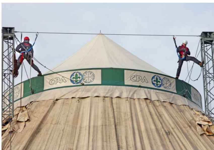
Arena Friedensau Aufbau
